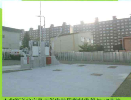
▲北海道北広島市災害時燃料備蓄タンク基地
